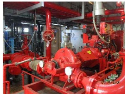
ภาพที่ 2.2-26 เครื่องสูบน้ำสำรอง
